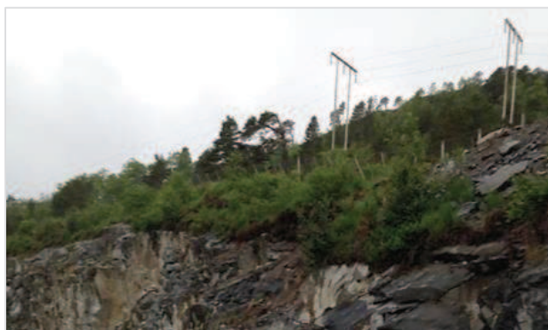
Figur 7-1 Bruddkant og luftledninger sett fra pukkverket
