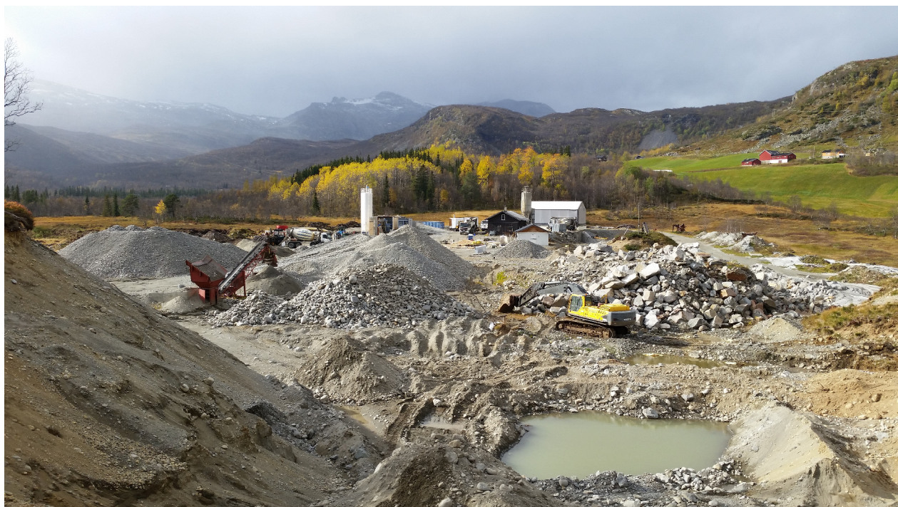
Fra riggområde i forkant av uttaket – mot vest – november 2014. I bakgrunnen 200 meter vest for riggplassen - med osp og bjørk i høstfarger, ses område for nytt masseuttak som skal planlegges på naboeiendommen Skredbergene.
