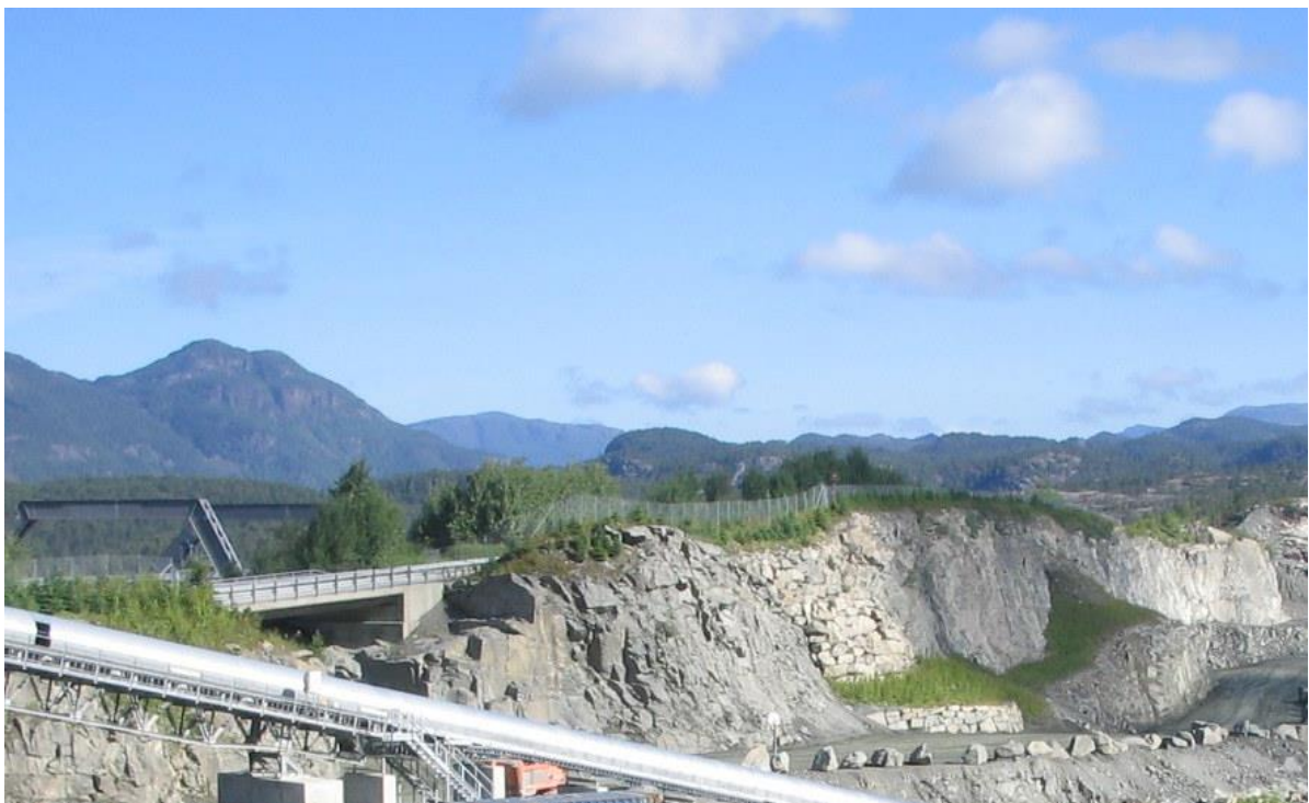
Bilde 8: Sikringsgjerde mot riksvei.
