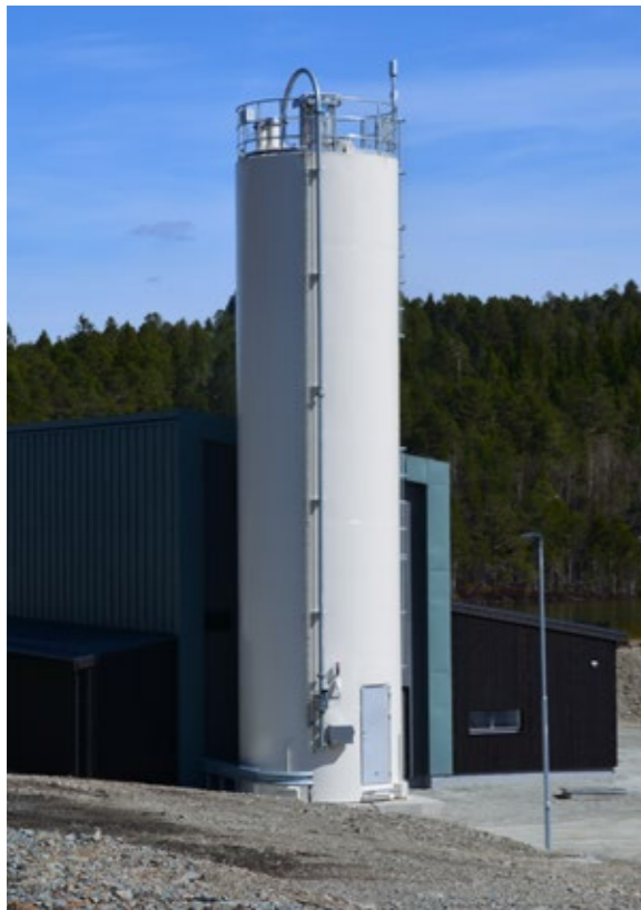
Nøytraliseringsanlegget på Løkken er det eneste i sitt slag Norge og Skandinavia.
