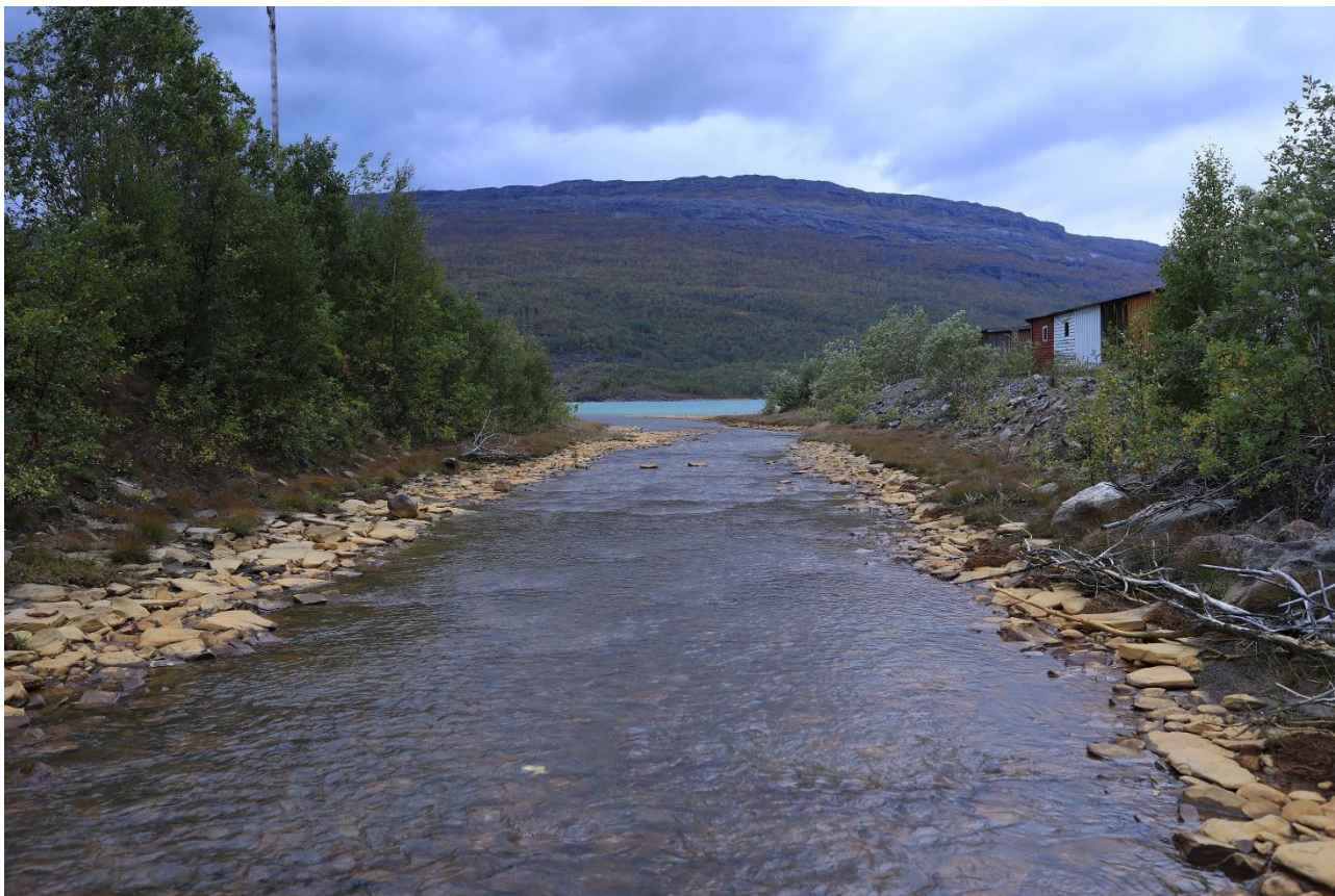
Figur 1-2. Bildet viser Giken ved utløpet til Langvatnet (foto: Norconsult).
