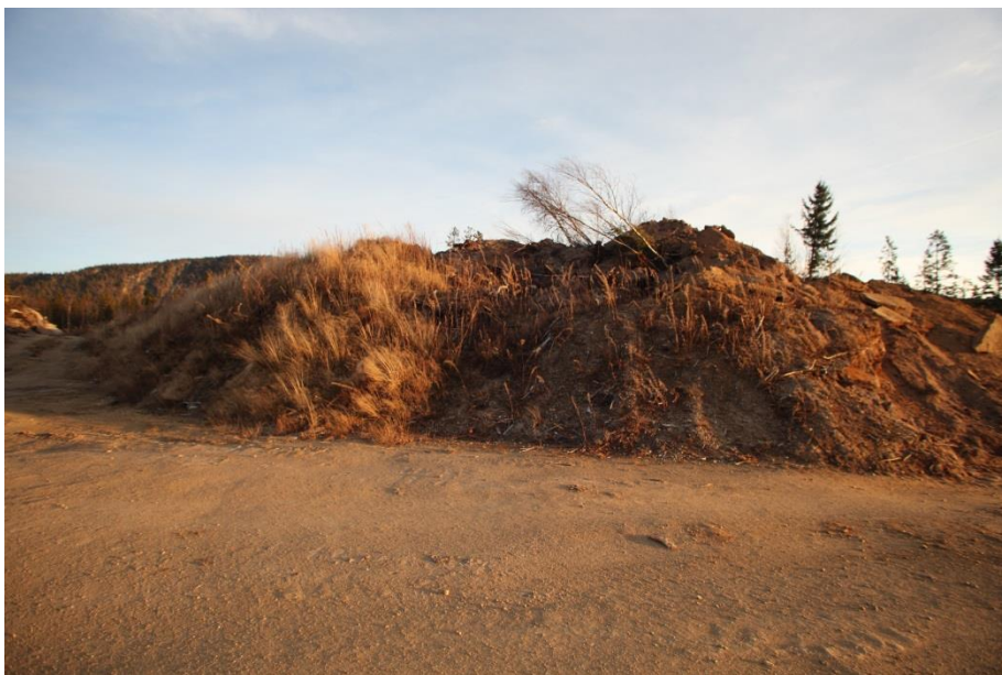
Figur 15: Avdekkingsmasser som er lagt til side som midlertidig skjermingsvoll.
