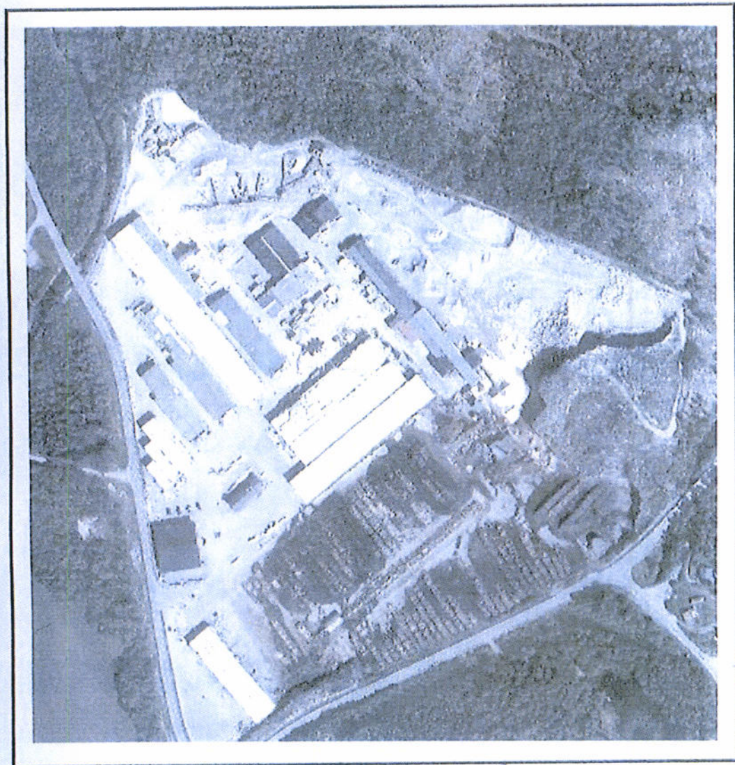
Flyfoto Haslestad Bruk ( 2007 ) Pukkverket ligger i nordre/nordøstre del av industriområdet.
